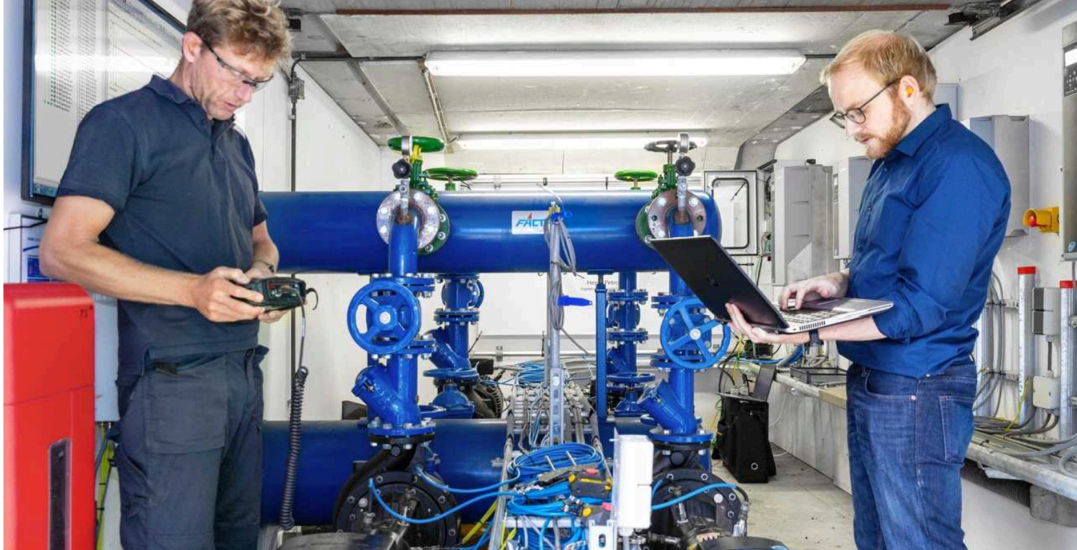
Vier elektromotor/pomp combinaties zijn voorzien van 'genormeerd defecte' componenten. Hiermee wordt onderzocht in hoeverre stroom- en spanningsmetingen zijn te gebruiken om defecten en slijtage op te sporen
